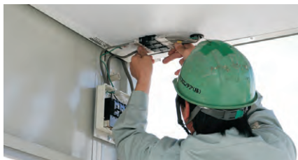
現場での施工がより簡単に
