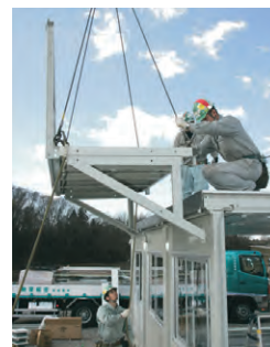
1階屋根部分から歩廊を設置
