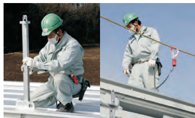
安全を確保した屋根上作業
