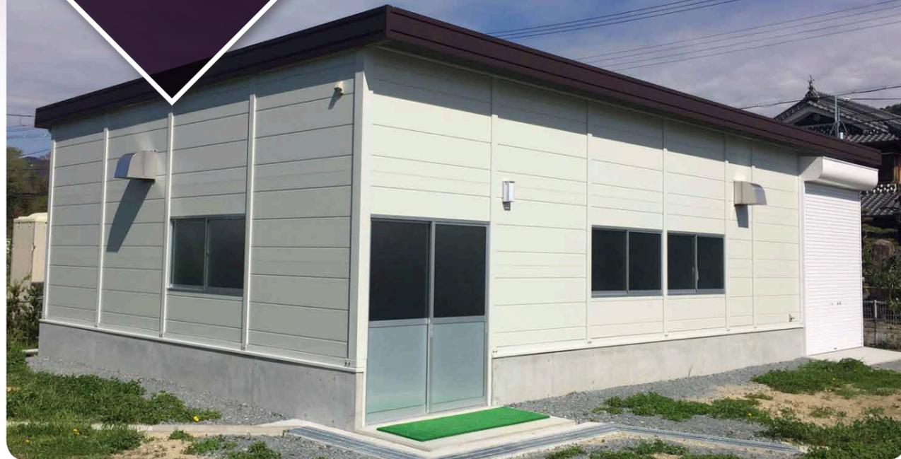
外壁パネルに断熱材を充填したタイプです。
